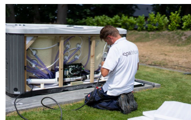
Unser Techniker schließt den Whirlpool an die Zuleitung an.
